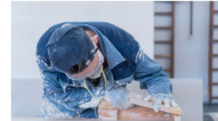
сухое строительство и штукатурные работы
